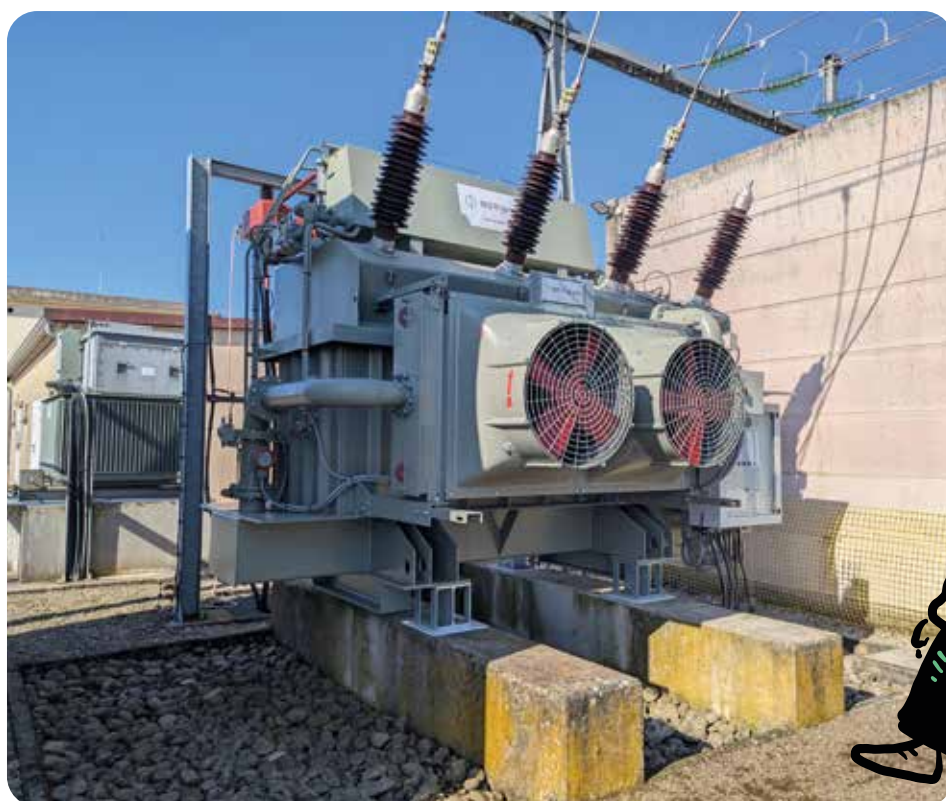
◀ Transfo réhabilité et installé à la SICAE EST.
